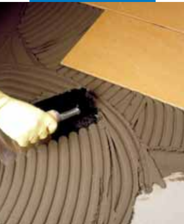
Απλώνοντας την Elastorapid πάνω σε τσιμεντοκονίες με οδοντωτή σπάτουλα
