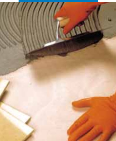
Τοποθετώντας τεχνητό γρανίτη με Elastorapid σε υπόστρωμα από κόντρα πλακέ θαλάσσης
