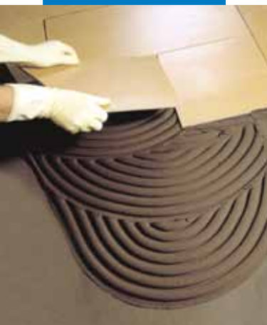
Τοποθετώντας τεχνητό γρανίτη με Elastorapid σε τσιμεντοκονίες που αδιαβροχοποιήθηκαν με Mapelastic
