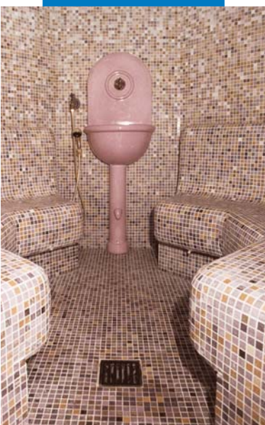
Ένα παράδειγμα τοποθέτησης υαλοψηφίδας σε τουρκικό λουτρό Ξενοδοχείο Park Gritti - Bardolino (Βερόνα), Ιταλία
