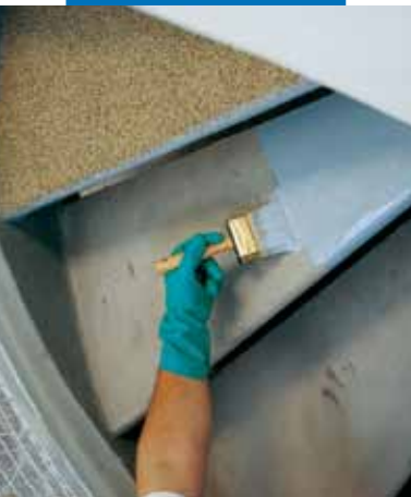
Εφαρμογή πρώτης στρώσης Mapescoat I 24 σε σκυρόδεμα
