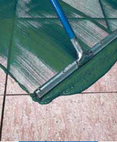
Αρμολόγηση με Ultracolor Plus σε δάπεδο με ειδικό μάκτρο από καουτσούκ
