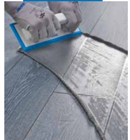
Εφαρμογή του Ultracolor Plus με λαστιχένια σπάτουλα σε τεχνητό γρανίτη που προσομοιάζει με ξύλο
