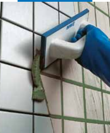
Αρμολόγηση με Ultracolor Plus σε τοίχο με ειδική λαστιχένια σπάτουλα
