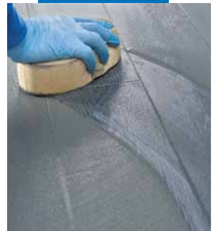
Τελείωμα και καθαρισμός αρμών πλακιδίων με σκληρό σφουγγάρι κυτταρίνης
