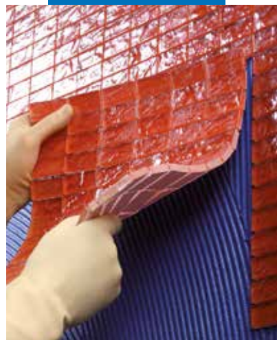
Τοποθέτηση υαλοπηφίδας σε τοίχο με Keraroxy Design
