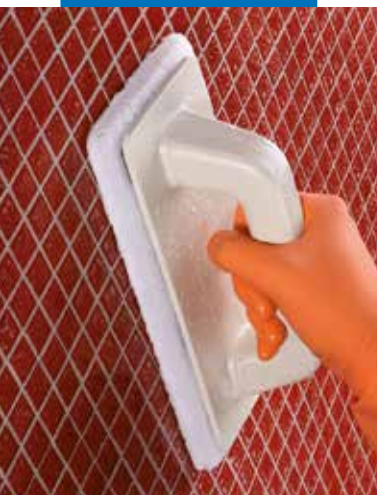
Καθαρισμός υαλοψιφίδας με ένα υγρό σφουγγάρι Scotch Brite®
