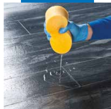
Διαβροχή της επιφάνειας του αρμόστοκου πριν τον καθαρισμό
