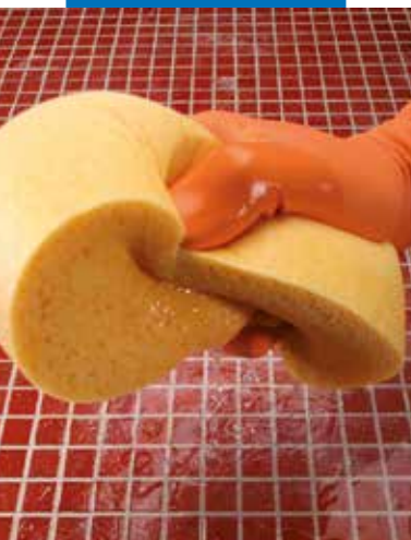
Διαβροχή της επιφάνειας του αρμόστοκου πριν τον καθαρισμό
