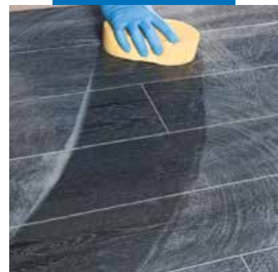
Τελείωμα και καθαρισμός αρμών πλακιδίων με σκληρό σφουγγάρι κυτταρίνης
