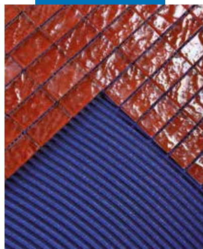
Την επόμενη ημέρα, αρμολόγηση με Keraroxy Design ίδιου χρώματος ακολουθώντας τον τρόπο εφαρμογής που παρουσιάστηκε προηγουμένως
