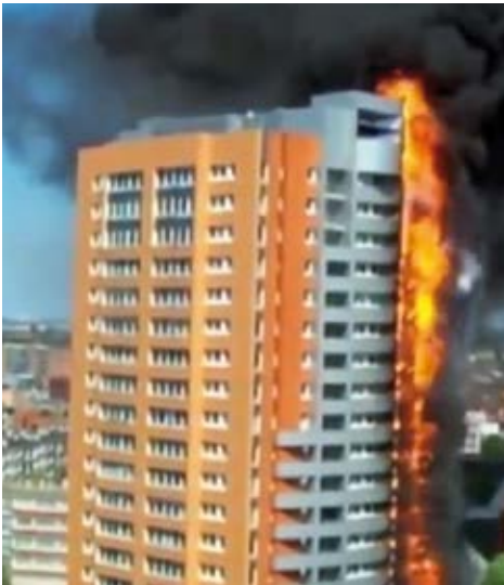
Πυρκαγιά στη Γαλλία σε θερμοπρόσοψη με EPS
